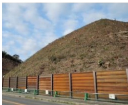
（高台の建設の様子）
